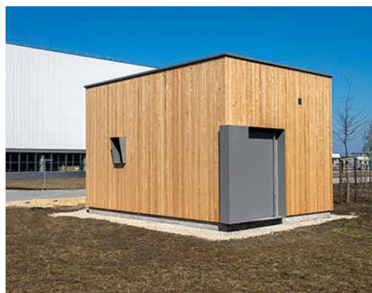
Das Gebäude, in dem sich der Hightech-Bienenstock Smart HOBOS befindet (Foto: AUDI AG)
