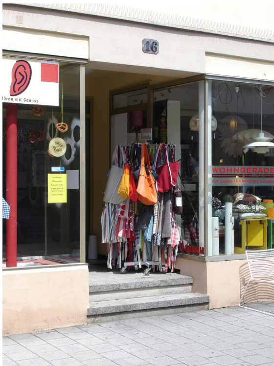
Abb. 47: Stufen vor Geschäftseingang (Erlangen)
