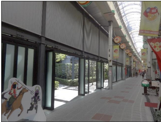
Abbildung 80: Versetzter Neubau in der Tamatsukuri Shoutengai in Tennoji
