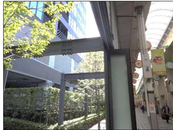
Abbildung 81: Versetzter Neubau in der Tamatsukuri Shoutengai in Tennoji
