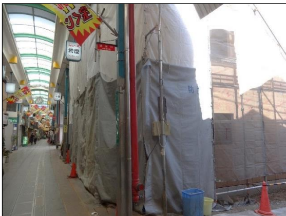
Abbildung 82: Ein im Umbau befindliches Gebäude in der Shoutengai in Abeno / Osaka
