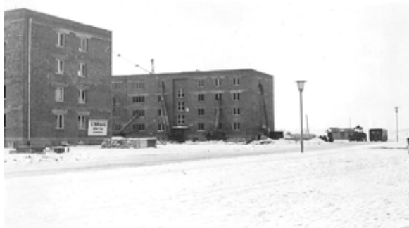
Die Wohnhäuser am Leighton Areal im Rohbau.
