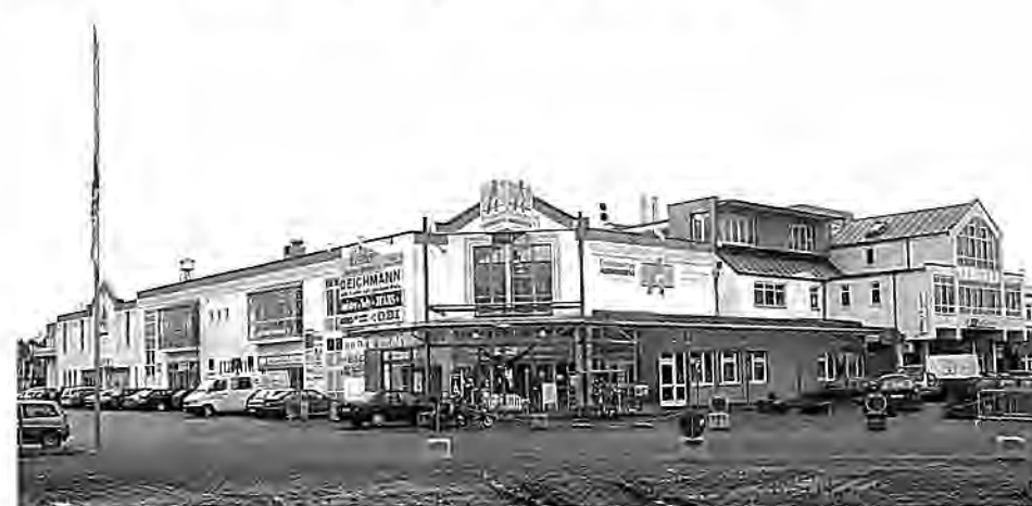
Foto 4: Einkaufszentrum Abensberg – letzter Bauabschnitt: die Mall
