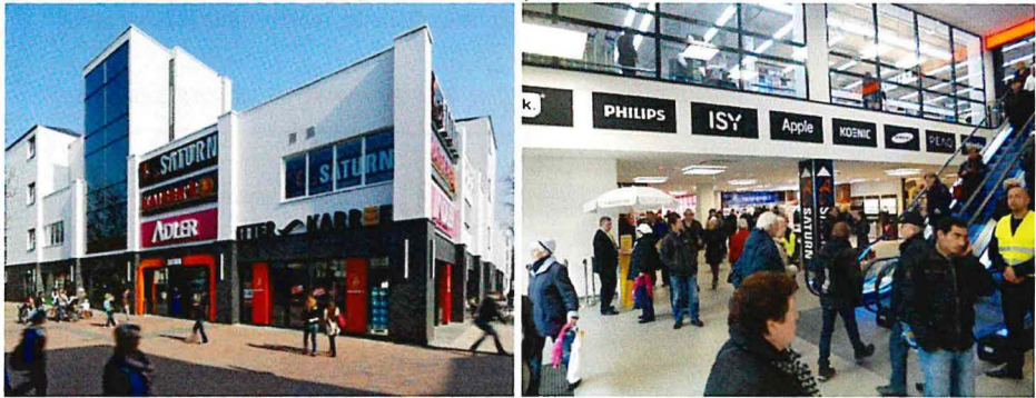
Abb. 9: Außen- und Innenansicht des Itter-Karrees, Hilden
