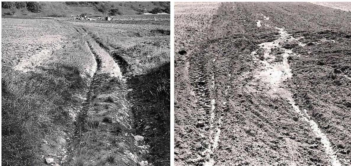
Abb. 85 Links: Hangabwärts verlaufender Weg. Schmale Räder lockern den Untergrund bis zum anstehenden Muschelkalk. Tiefenerosion setzt sich bei Oberflächenzufluss aus einem oberhalb befindlichen Einzugsgebiet fort. Je nach Reliefsituation kommt es bei weiterem Verlauf zu Ausbildung von Hohlwegen. Foto 1958 am Hunsenberg gegenüber Impfingen. Rechts: Fahrspuren eines Traktors auf einem gepflügten Feld nehmen hangabwärts von einem Weg zugeleiteten Oberflächenabfluss auf und leiten (hier vorübergehende) Tiefenerosion ein (vgl. Abb. 53).
