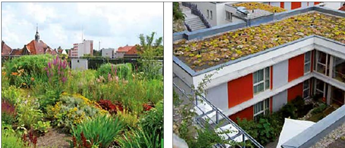
Abbildung 4: Gegenüberstellung intensiver (links) und extensiver (rechts) Dachbegrünung.
