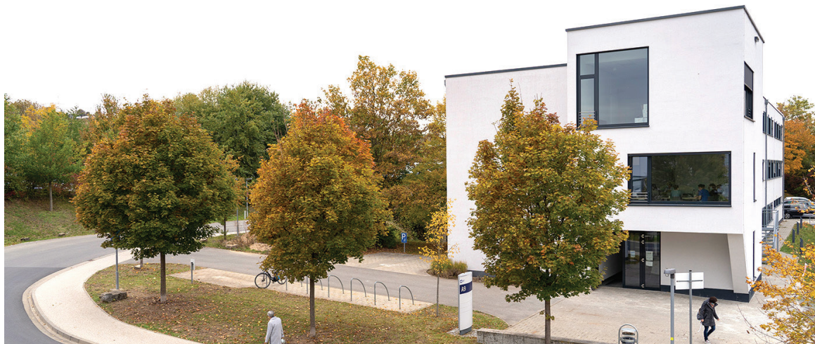
Das Gebäude A9 ist der neue Standort des Zentrums für interdisziplinäre Schmerzmedizin des Uniklinikums Würzburg. Foto: Anna Wenzl / UKW
