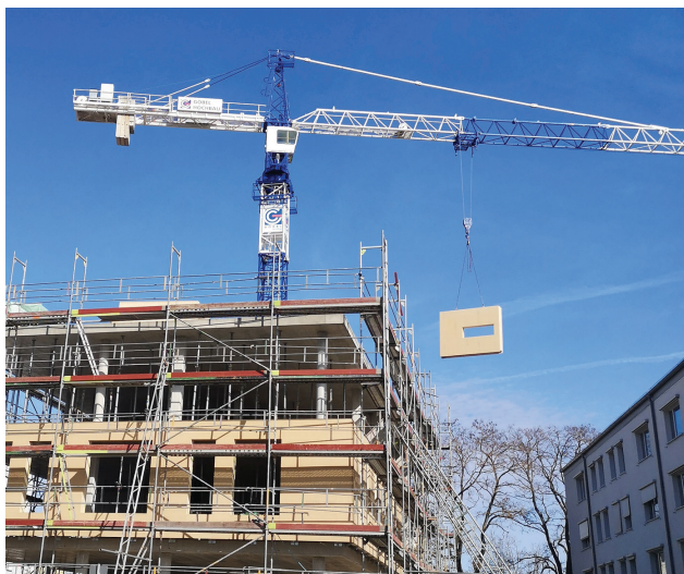
Einbau der vorgefertigten, elementierten Fassade in Holztafelbauweise. Foto: Staatliches Bauamt.
