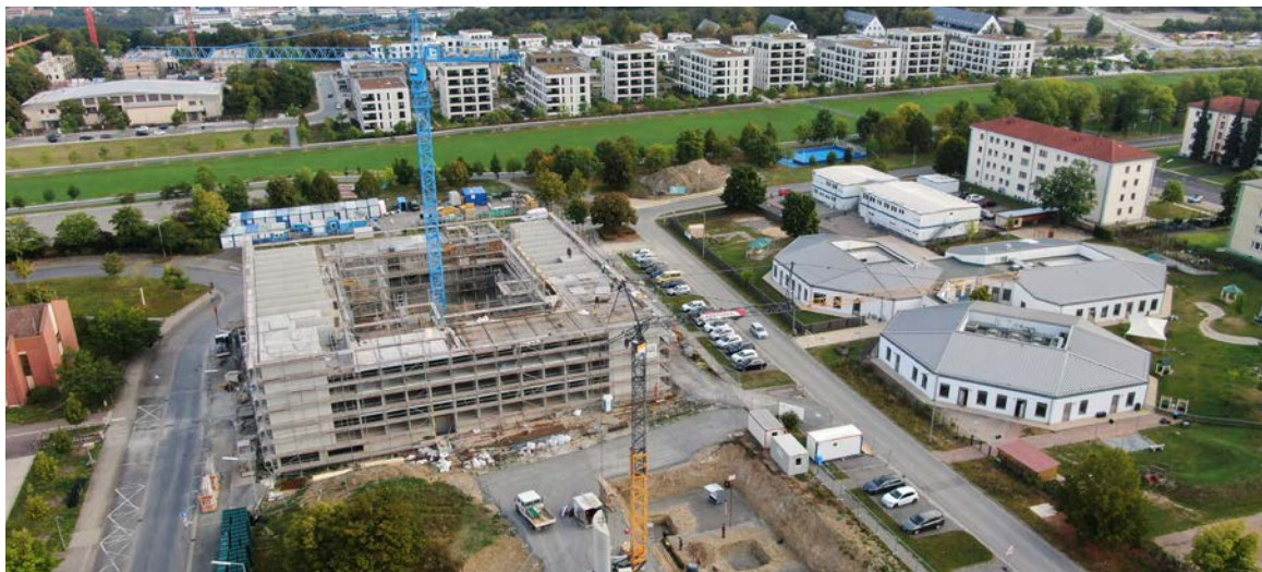
Die Baugrube für den Neubau des DZPP. Direkt dahinter der Rohbau für ein neues Wohnheim des Studentenwerks, rechts die Waben des Kinder- und Familienzentrums der Universität. (Bild: Staatliches Bauamt Würzburg)
