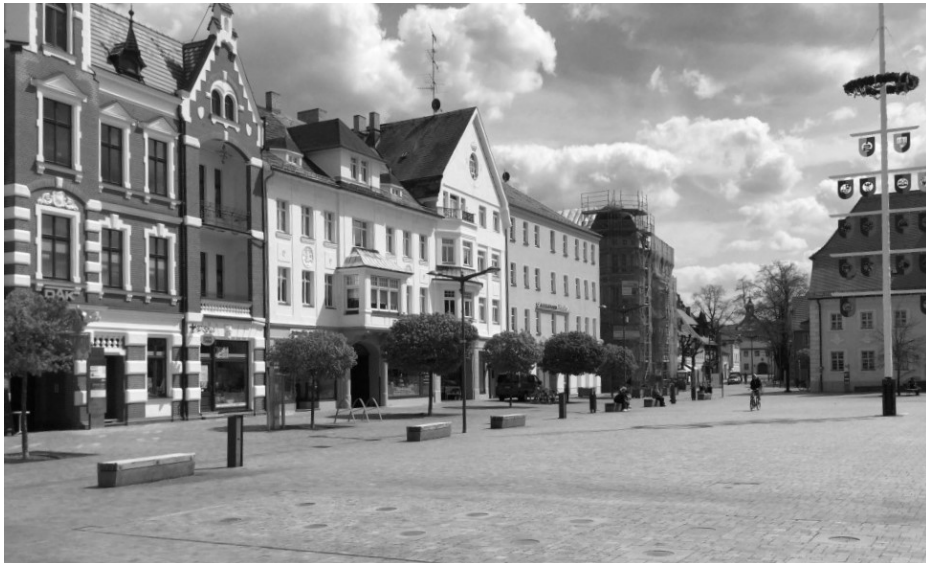
Abbildung 7: Blick über den Marktplatz in Finsterwalde
