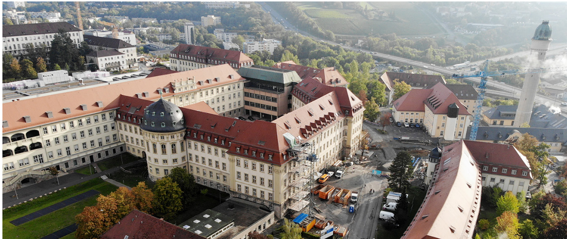
Der Medizin-Campus in Grombühl. In der Mitte das Gebäude D20, in dem das Institut für Anatomie und Zellbiologie der Universität Würzburg in Zukunft untergebracht sein wird. (Foto: Staatliches Bauamt Würzburg)
