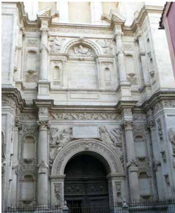
Fig. 4: Diego Siloé, Puerta del Perdón , Cathédrale de Grenade, 1530-1535. Photographie de l'auteur.
