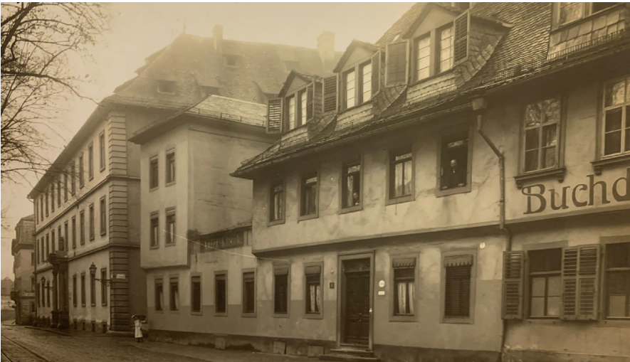
Abb. 7: Blick auf die Arenssche Augenklinik in Richtung Pleicher Schule; Archiv des Klosters Oberzell, Akte 262.
