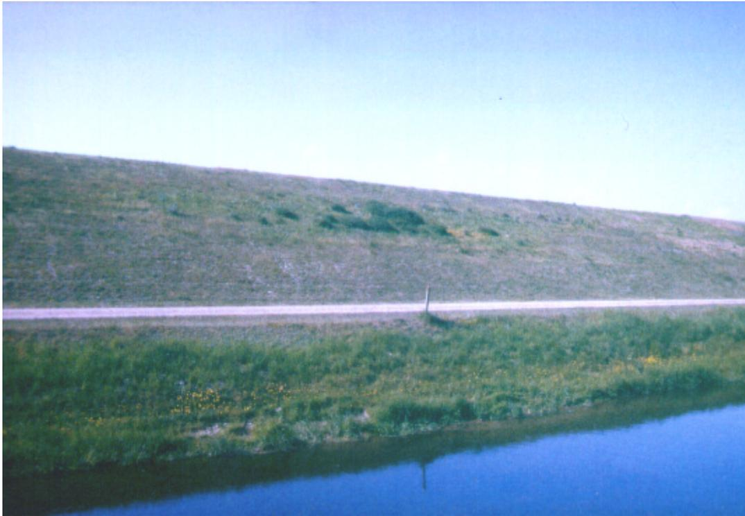
Abbildung 5.1: Verstärktes Pflanzenwachstum auf der binnenseitigen Dammlinke im Bereich einer Leckage. Östlicher Rheinseitendamm bei km 307550.
