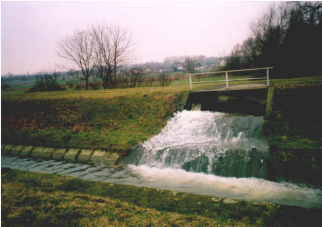
Abbildung 6.11: Einlassbauwerk. Ein Teil der aus der Grundwasserabsenkung in Wiescherhöfen (im Bildhintergrund) anfallenden Wassermenge wird dem Wiescher Bach über dieses Einlassbauwerk zugeleitet.
