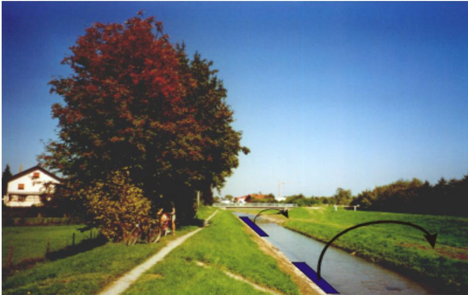
Abbildung 3.2: Wartungsarbeiten an einem Flussschiff. Der Aushub (blau) wird aus dem Niedrigwasserquerschnitt entfernt und erneut innerhalb des Hochwasserquerschnitts deponiert (Pfeilspitzen). Sandbach in Bühl / Baden.
