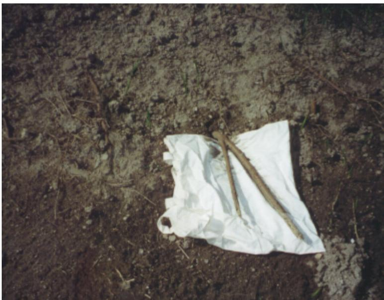
Abbildung 3.1: Wurzelaustritt an einem Erddeich. Die weiße Kontrastfläche ist etwa 40 x 40 Zentimeter groß. Sandbach bei Bühl / Baden.
