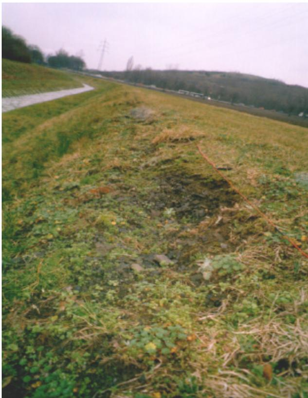
Abbildung 4.1: Von Erosion betroffene Deichkrone. Im Bereich der ehemaligen Kante sind lediglich noch Residuale (dunkelgrau) im Mittel- bis Grobkiesbereich vorhanden. Der Feinkornanteil wurde erodiert. Deich des Wiescher Bachs bei Wiescherhöfen.
