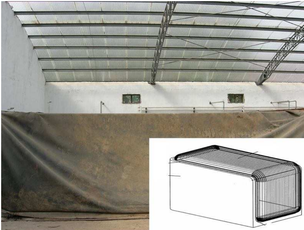
Abbildung 5-28: Liegender Fermenter mit dem Gasspeicher und das originale Design-Bild des China-Beispielprojekt 3 in China (CHENXING WANG & XIN XIANG)
