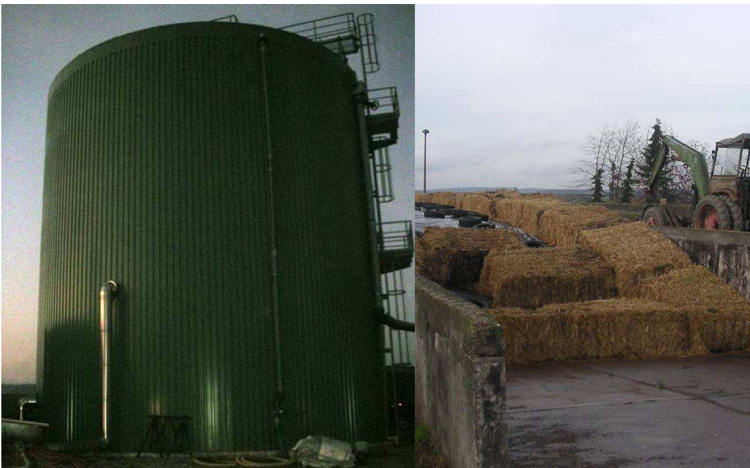
Abbildung 5-11 : Foto von der Deutschland-Beispielanlage 2 (links: Hauptfermenter, rechts: Silage) (Fotos von CHENXING WANG)
