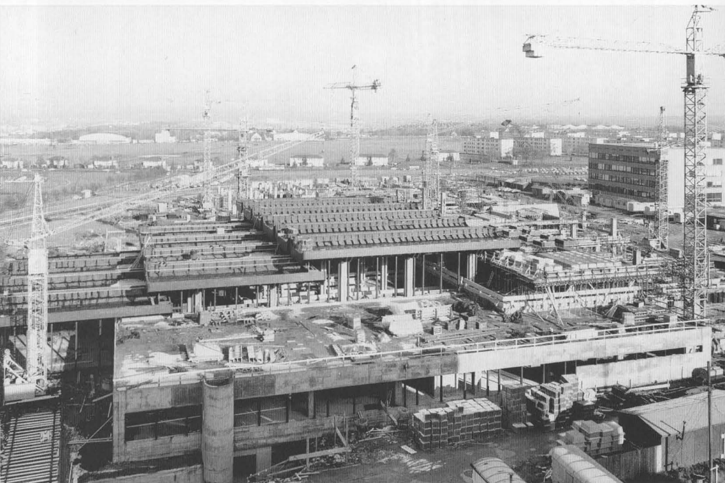
3: Die alte Universitätsbibliothek an der Domerschulstraße während des Wiederaufbaus im Jahre 1946. – 4: Großbaustelle auf dem Erweiterungsgelände "Am Hubland" (Mensa, dahinter Bibliothek), November 1975
