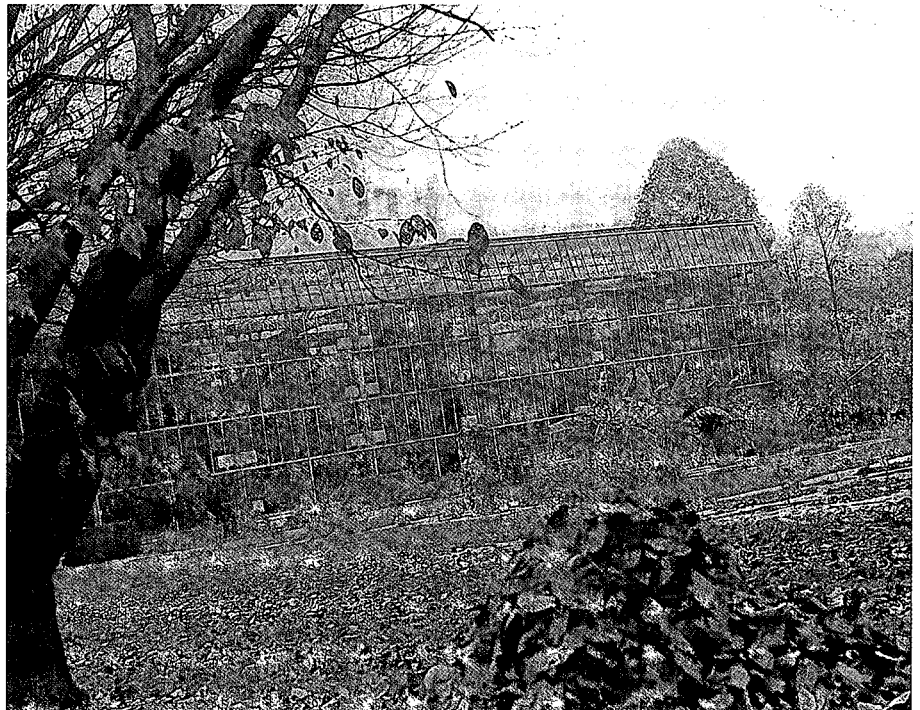
Auch die Verglasung der Schau- und Anzuchthäuser im Botanischen Garten soll im Rahmen des Sanierungskonzepts erneuert werden.
