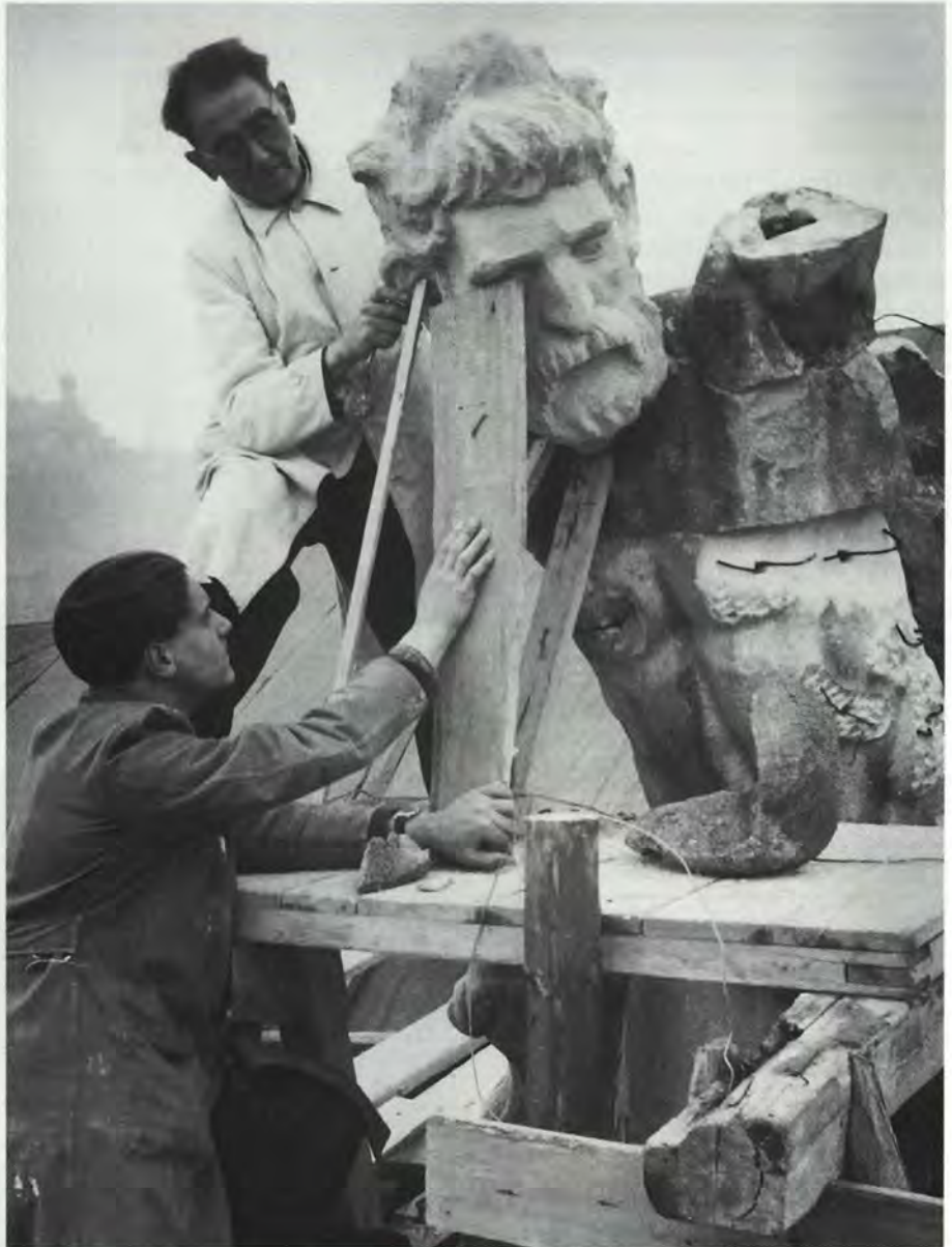
Jetzt nur nicht den Kopf verlieren - die beim Bombenangriff auf Würzburg stark beschädigte Figurengruppe auf dem Dach der Neuen Universität wurde im Jahr 1950 restauriert. Bildhauer Schneider setzt Prometheus ein neues Haupt auf. Archivfoto des Universitätsbauamtes
