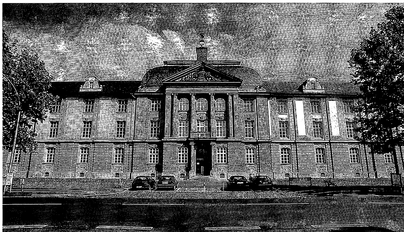
Vor 100 Jahren, am 1. Oktober 1898, wurde das „Königliche Schullehrerseminar“ eingeweiht. Heute trägt der Bau den nüchternen Namen „Universitätsgebäude Wittelsbacherplatz 1“. Foto: Heinz Jakob
