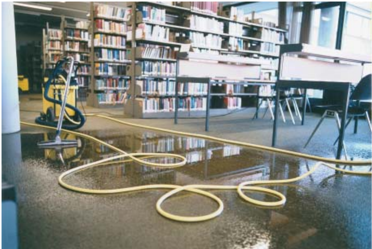
Wasserrohrbruch in der Teilbibliothek AGR am 04.02.2002 (Bericht s. S. 52)
