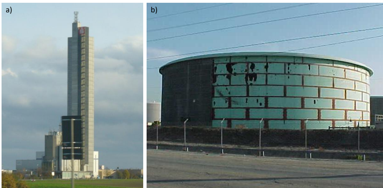
Abbildung 3: a) Getreidesilo Schapfenmühle (Höhe 114,6 m); b) Öltank, Golden West Refinery (Bilder veröffentlicht unter der GNU Free Documentation License unter de.wikipedia.org )
