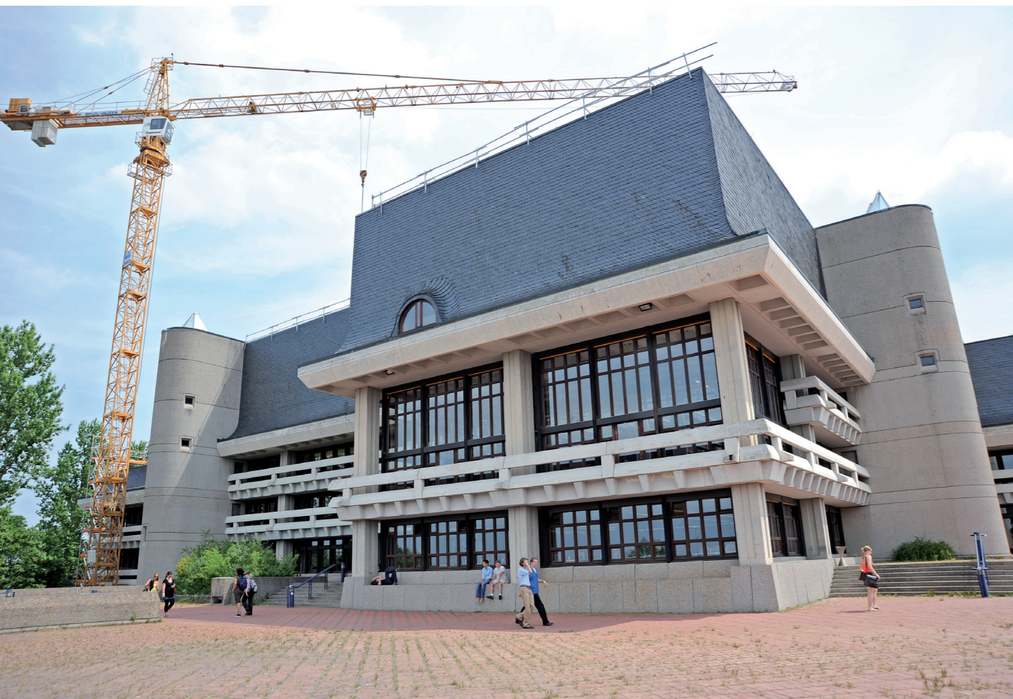
Bauarbeiten während der Dachsanierung der UB
