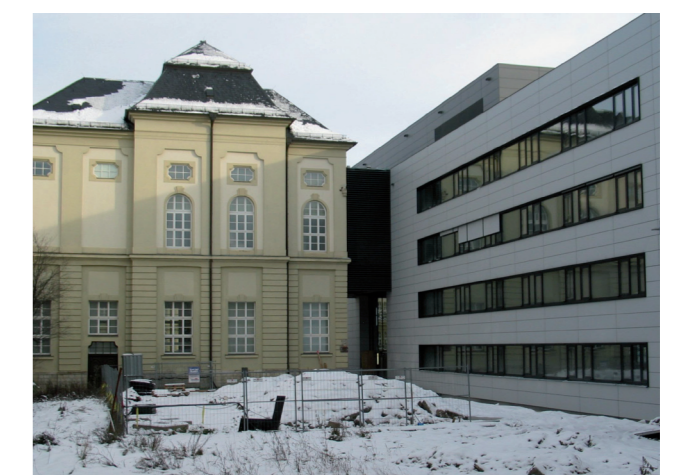
Der neue Gebäudeteil der Teilbibliothek Wittelsbacherplatz und die Arbeiten während der Abbruchphase
