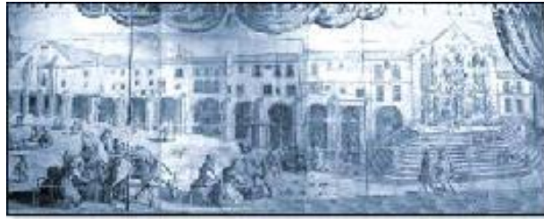
Abbildung 14: Fassade des Krankenhauses von “Todos Os Santos”. 230
