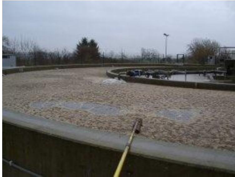
Abbildung 14: SchwimmSchlammdecke auf einem Belebungsbecken ( www.zerberus-online.de , 2010). Durch Anlagerung von Gasbläschen an den Belebtschlamm flotiert der Schlamm an die Wasseroberfläche.
