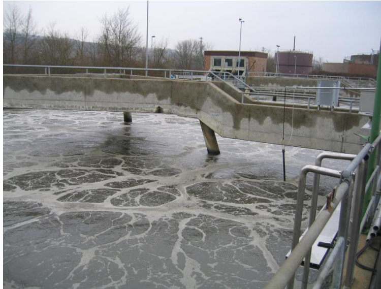
Abbildung 5: Belebungsbecken einer kommunalen Kläranlage in der belüfteten Phase. (Foto: Knaf)
