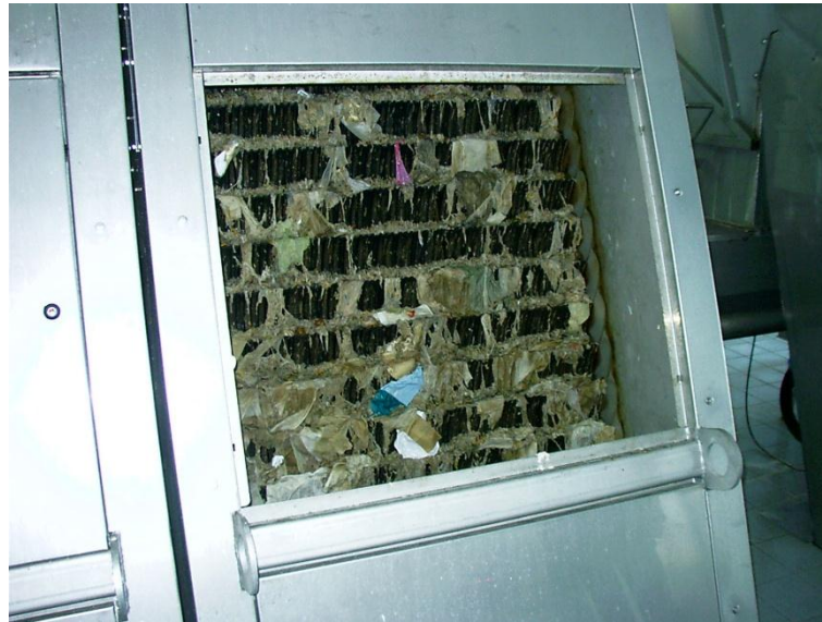
Abbildung 2: Recheneinheit zur Entfernung von Grob- und Müllstoffen aus dem Abwasser. (Foto: Knaf)
