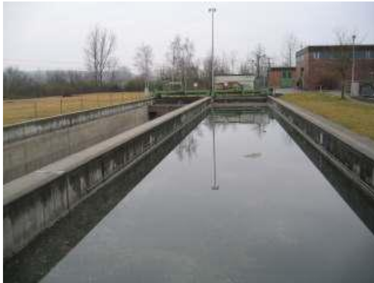
Abbildung 4: Vorklärung zur Abtrennung von Feststoffen aus dem Abwasser, wodurch bereits große Mengen des CSBs eliminiert werden können. Aufgrund einer gradientenförmigen Herabsetzung der Fließgeschwindigkeit setzen sich schwerere Feststoffe am Beckenboden ab beziehungsweise leichtere Feststoffe schwimmen an der Wasseroberfläche auf und können somit dem Abwasser entzogen werden. (Foto: Knaf)
