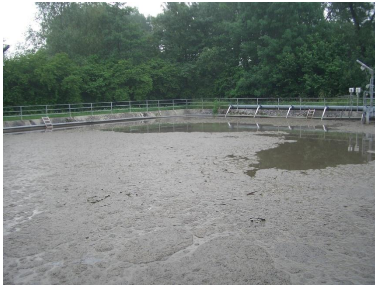
Abbildung 9: Schwimmschlammdecke auf der Oberfläche eines Belebungsbeckens während der unbelüfteten Phase. Aufgrund nicht ausreichend hoher Dichte des Belebtschlammes kann sich dieser nicht mehr komplett absetzen und schwimmt an der Oberfläche auf (Schwimmschlamm) bzw. schwebt im Wasser (Blähschlamm). (Foto: Knaf)
