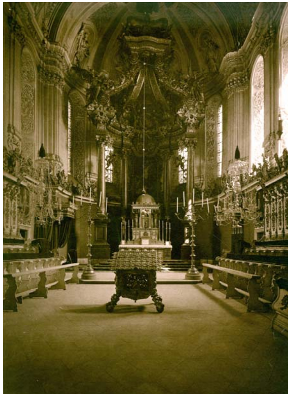
Bild 11: Würzburger Dom Chorraum vor der Zerstörung
