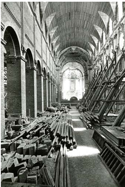
Bild 13: Würzburger Dom Mittelschiff mit Holzlattengewölbe und gestützter Südwand 1956
