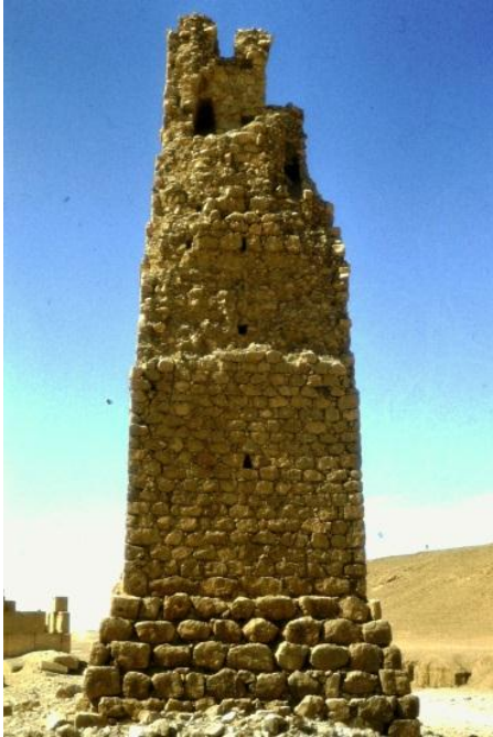
Syrien10 zerstörtes Turmgrab, Palmyra
