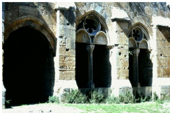
Syrien106 Bau mit Rittersaal, Krak des Chevaliers
