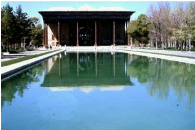
Iran42 Tschehel Sotun, 40 Säulen-Palast, Isfahan
