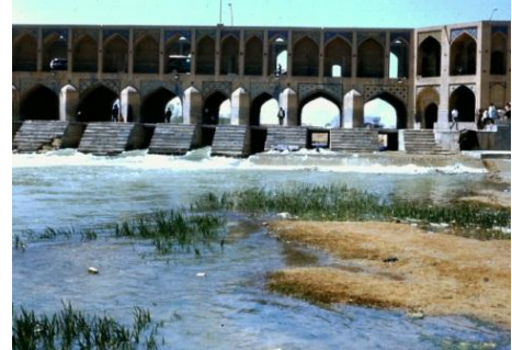
Iran73 Kadju Brücke, Isfahan
