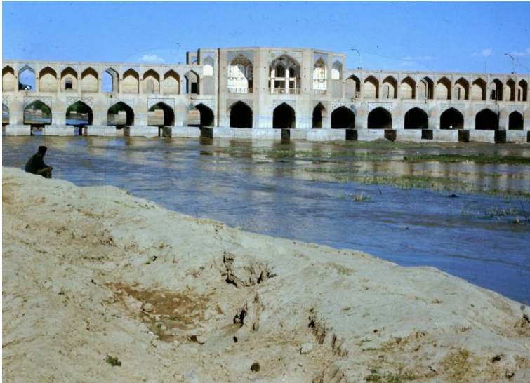
Iran72 Kadju Brücke, Isfahan
