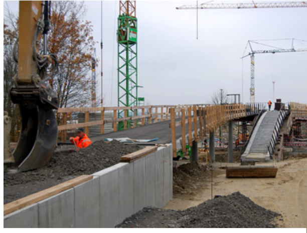
Die neue Brücke über die Straße am Galgenberg. Dank einer geringen Steigung kann sie auch von Rollstuhlfahrer benutzt werden. (Alle Fotos: Judith Dauwalter)
