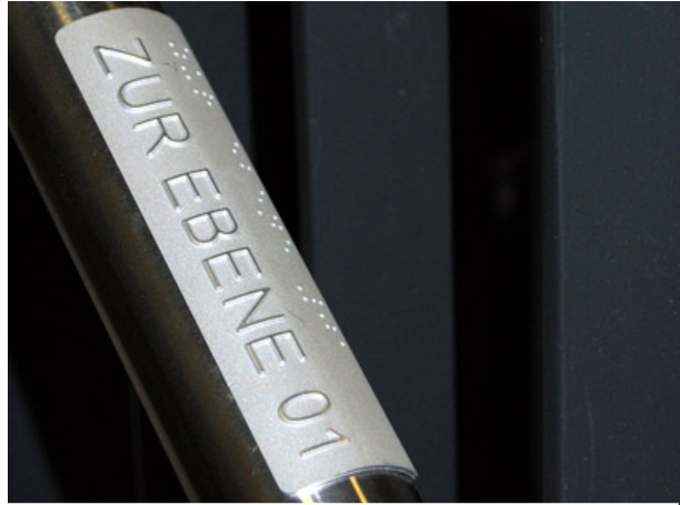
Wegweiser in Blindenschrift lassen sich mit geringem Aufwand anbringen.
