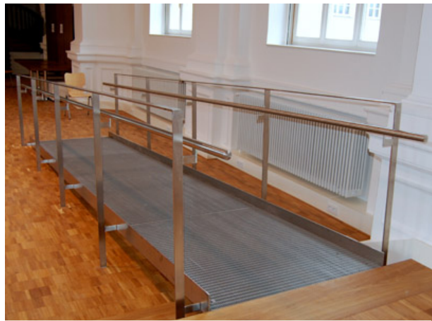
Auch eine Rampe lässt sich in vielen Fällen leicht nachrüsten.
