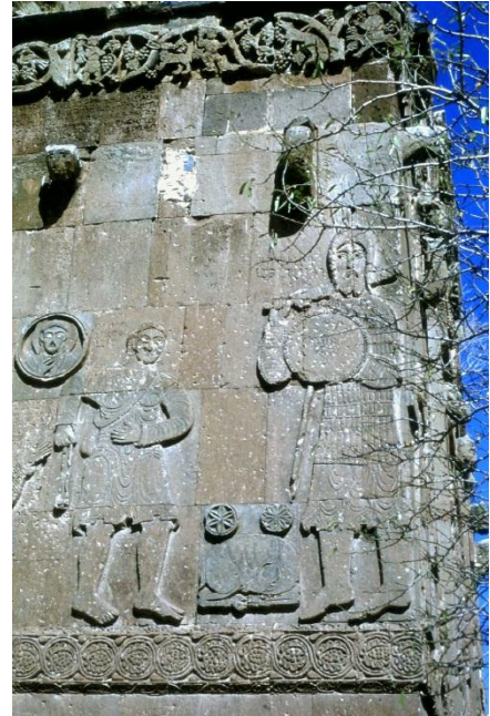
OTürkei69 Ahtamar, Südfassade
