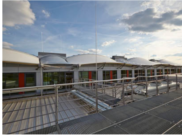
Dachansicht des Energy Efficiency Centers mit seinen lichtdurchlässigen Membranen zur Tageslichtbeleuchtung. (Foto: ZAE Bayern, Petra Hoeglmeier)
