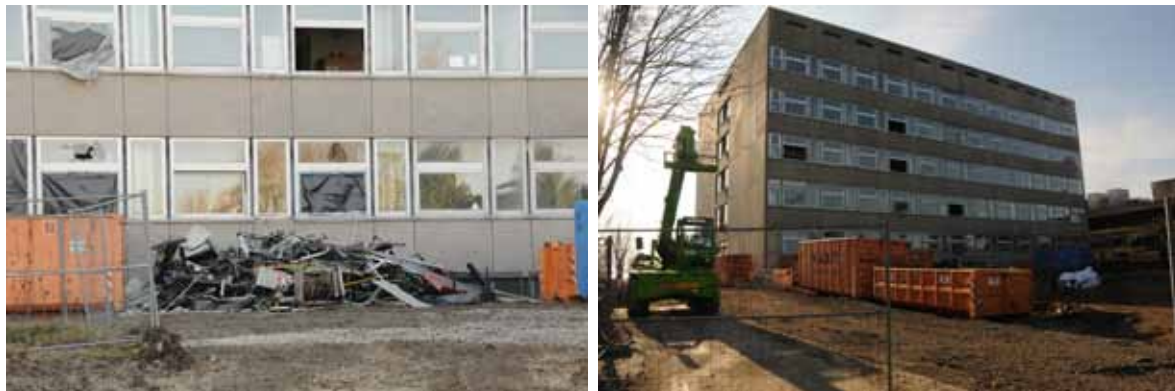
Der Rückbau des früheren Instituts für Organische Chemie ist im Gange. (Fotos: Robert Emmerich)
