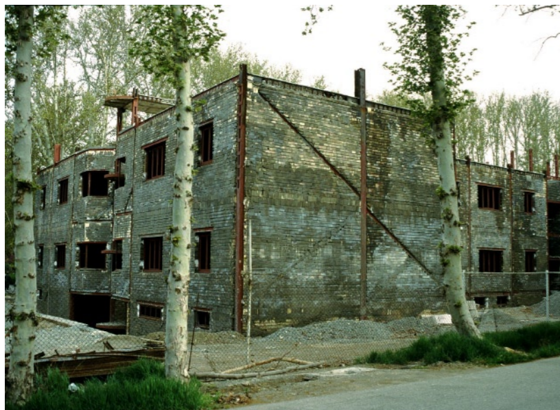
Abb. 19: ▼ Photo i9-02-12: Stahlskelettbauweise zur Sicherung gegen Erdbebenschäden, Campus der Faculty of Natural Resources in Karaj
