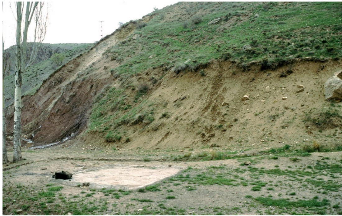
Abb. 120: ► Photo i34-02-23, GPS-Punkt AL8, 1969 m NN: Fuß des Rutschungskörpers im Bereich des Straßenanschnittes. Der Quellaustritt links im Bild und der inhomogene Materialverband sind charakteristisch für Rutschungsmassen.
