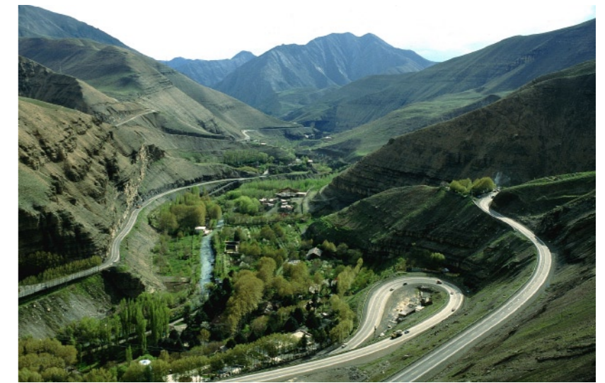
Abb. 3: Photo i25-02-10: Gebirgspass nördlich von Karaj. Im Untersuchungsgebiet treffen eine Vielzahl an Faktoren zusammen, welche Massenbewegungen begünstigen, z.B. Steilheit des Reliefs, karge Vegetationsbedeckung oder Hangunterschneidung durch Straßenbau und Flüsse.
