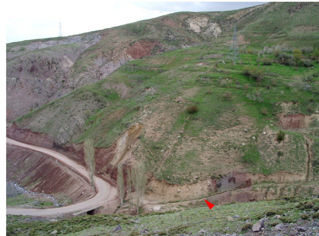
Abb. 134: ◀ Photo 04250021, GPS-Punkt AL8, 1969 m NN: Straßenanschnitt und Wasserleitung (roter Pfeil) am Fuß eines großen Rutschungskörpers
