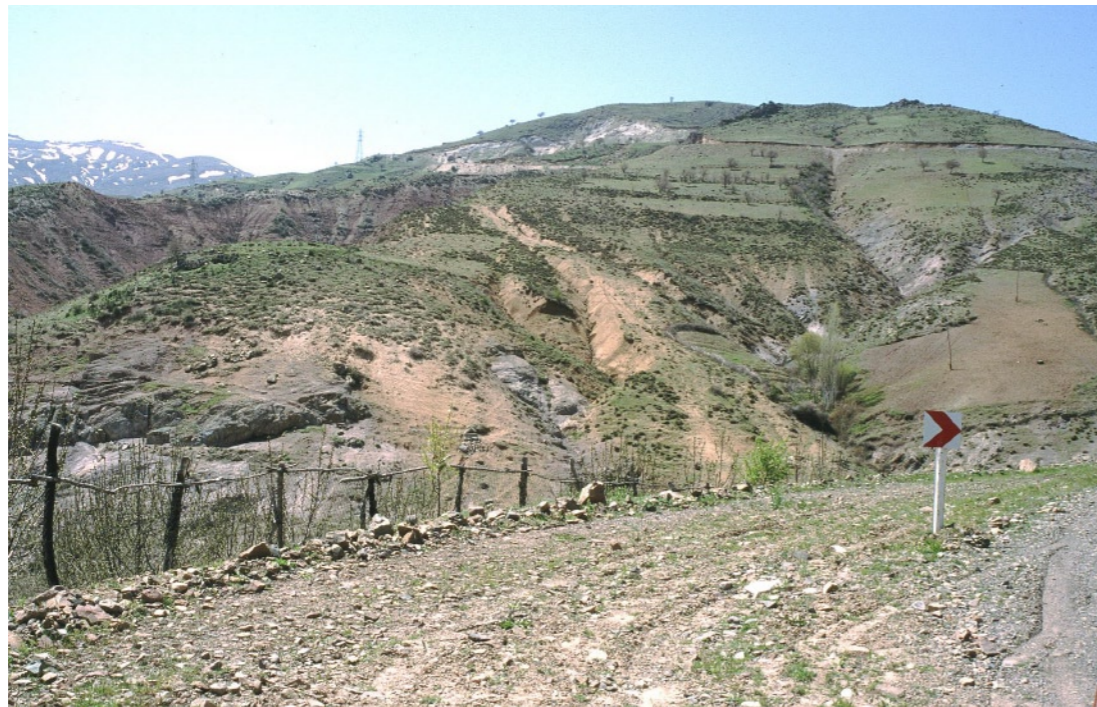
Abb. 125: Photo i15-02-09, nahe GPS-Punkt KKRUST, 1719 m NN: im Testgebiet wird der Zusammenhang zwischen natürlicher Stabilität und anthropogener Nutzung an vielen Stellen ersichtlich. Auf der einen Seite sind im Bild Schäden an der Vegetationsdecke deutlich zu erkennen. Auf der anderen Seite handelt es sich bei der gesamten Bergform um eine sehr alte große Rutschungsmasse, die anthropogen genutzt wird.
