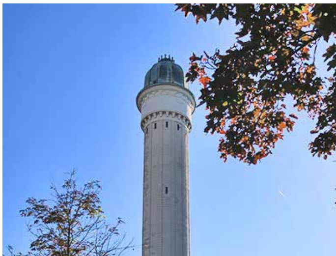
100 Jahre alt ist der 64 Meter hohe, das Stadtbild prägende Kamin des Heizkraftwerks des Universitätsklinikums Würzburg. (Foto: UKW)
