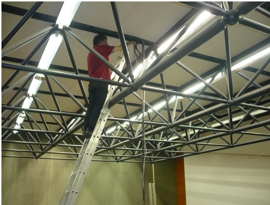
Abbildung 16: Beamerinstallation in einem Hörsaal der Chemie
