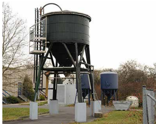
Hier lagern die Salzvorräte der Uni: in dem großen Silo im Vordergrund und in den beiden blauen Behältern hinten. (Foto: Gunnar Bartsch)
