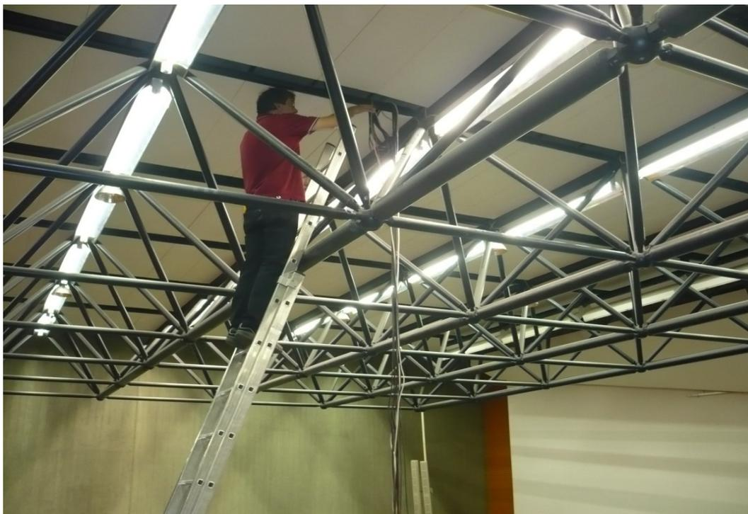
**Abbildung 17: Beamerinstallation in einem Hörsaal der Chemie**
