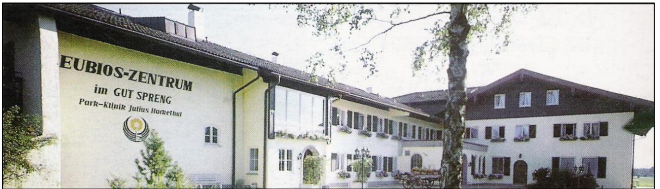
Abbildung 27: Das EUBIOS-Zentrum im Gut Spreng I 7
