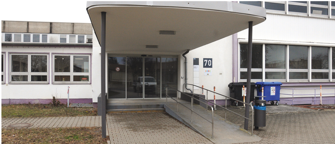
Bis 2023 soll auch die Universität Würzburg barrierefrei sein. Hier: der barrierefreie Zugang des Gebäude 70. (Bild: Gunnar Bartsch/Universität Würzburg)
