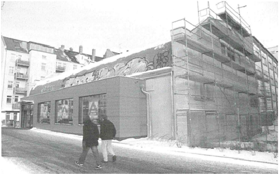
Abb. 8: ALDI in gründerzeitlicher Markthalle in Leipzig
