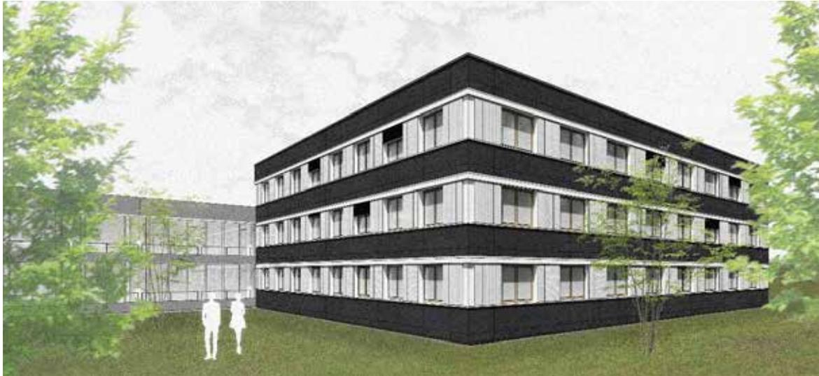
So soll die Fassade nach der Sanierung aussehen. Die Bürotrakte des Philosophiegebäudes sind dann von einer hochdämmenden, etwa 35 Zentimeter starken Hülle umgeben. (Bild: Werner Sobek, Frankfurt)
