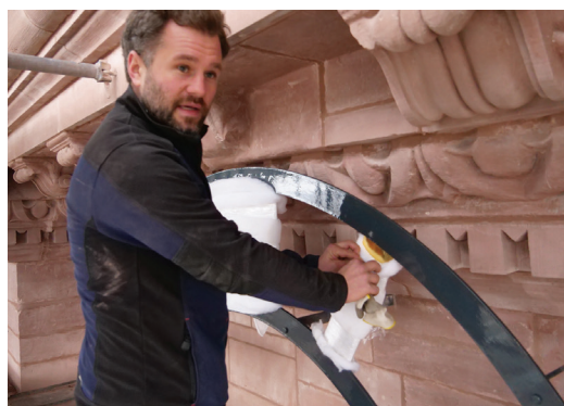
Unter der Folie schimmert das Gold. Ziffern und Zeiger haben die Bayreuther Uhrmacher mit 24-karätigem Blattgold versehen. (Bild: Kristian Lozina / Universität Würzburg)
