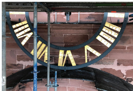
Das Zifferblatt vor der Renovierung. Aus der Nähe sind die schadhaften Stellen gut sichtbar. (Bild: Staatliches Bauamt Würzburg)
