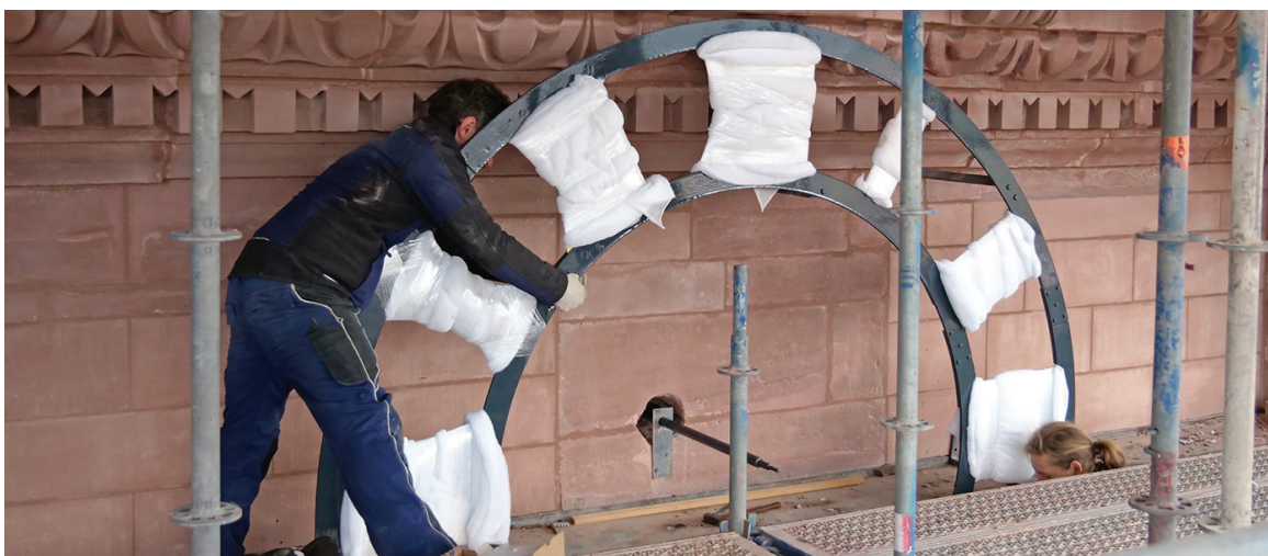
Montage in 48 Meter Höhe. Thomas Hollering von der Firma „Bayreuther Turmuhren“ hilft bei der Befestigung eines Zifferblatts. (Bild: Kristian Lozina / Universität Würzburg)
