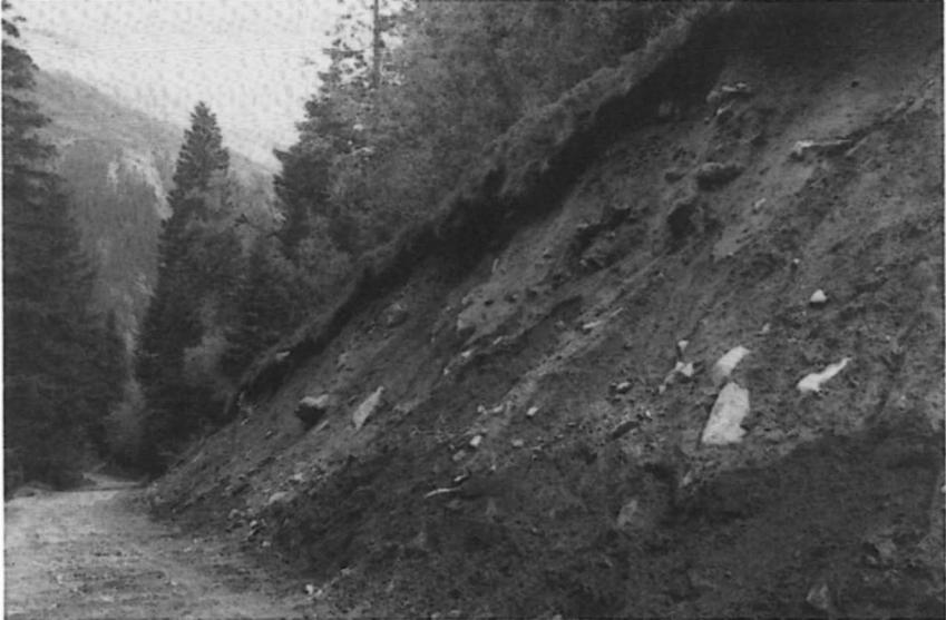
*Abb. 96: Anthropogen induzierte Hangübersteilung im Langental. Durch ständige anthropogen bedingte Hangunterschneidung kann die natürliche Selbststabilisierung nicht greifen. Photo: Blättler 1991*
