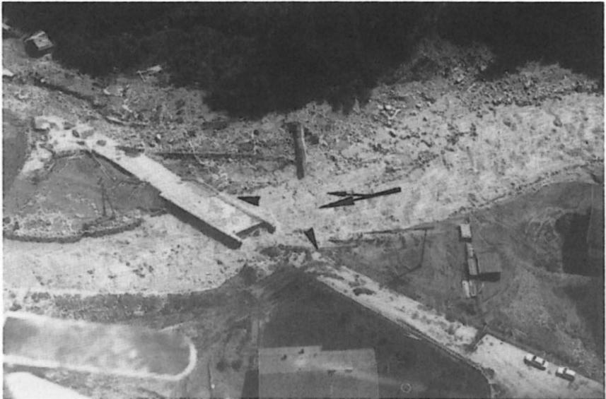
*Abb. 76: Landesstraßenbrücke bei Schaller 1987. Die andrängenden Wasser- und Schuttmassen verklausten die ungenügend dimensionierte Betonbrücke. Die Verklauung führte zum beidseitigen Ausbruch der Ruetz, die Brücke selbst blieb unbeschädigt. Photo: Wildbach- und Lawinenverbauung Innsbruck, 1987.*
