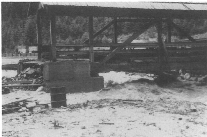
*Abb. 29: Brücke bei Schalter nach Durchgang der Hochwasserwelle. Deutlich sieht man die Au/schottern ng der Ruetz, und Reste der durch Unholz, ausgelösten Verklausung. Photo: Wildbach- und Lawinenverbauung Innsbruck 1978*
