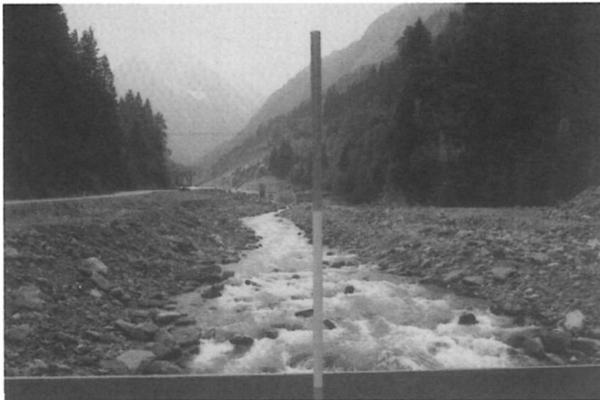
*Abb. 123: Falbeson/Bereich "zwischen den Wänden" 1991. Das nahezu vom gleichen Standpunkt wie Abb. 122 aufgenommene Bild verdeutlicht die umfangreiche anthropogene Einflußnahme durch den Bau der Stubaier Gletscherstraße. Der einst nur schmale Durchlaß "zwischen den Wänden" wurde für den Straßenbau verbreitert und die Ruetz verlegt und stark begradigt.
