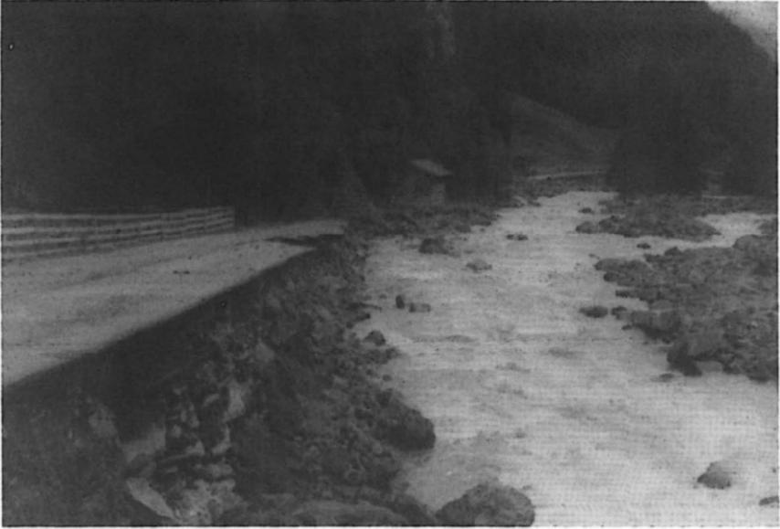
*Abb. 26: Umfangreiche Sohl- und Lateralerosion im Bereich „zwischen den Wänden“ bei Falbeson.
