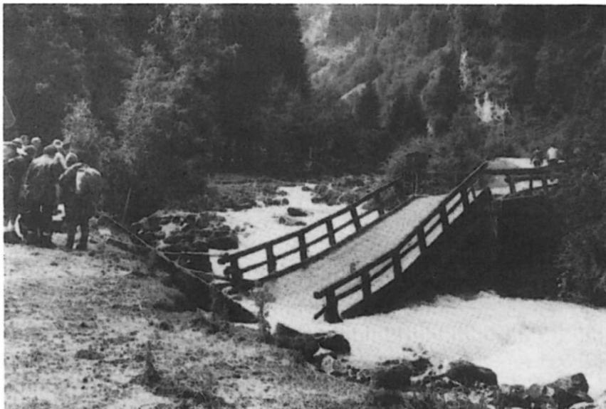
*Abb. 121: Durch das 78er Hochwasser zerstörte Brücke bei Falbeson im Bereich "zwischen den Wänden".
