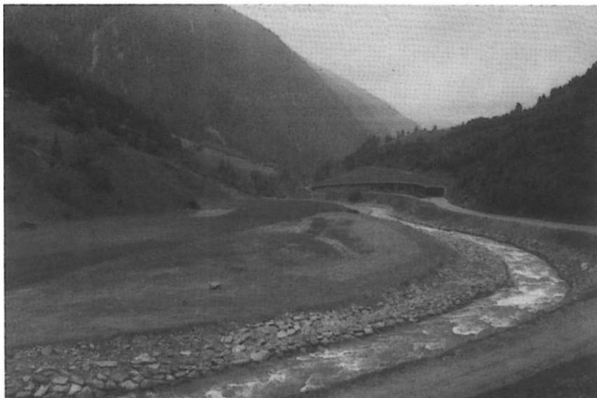
*Abb. 41: Ruetzregulierung (Leitwerkein loser Steinschichtung) bei Ranalt. (vgl. Abb.32 u, id49)
