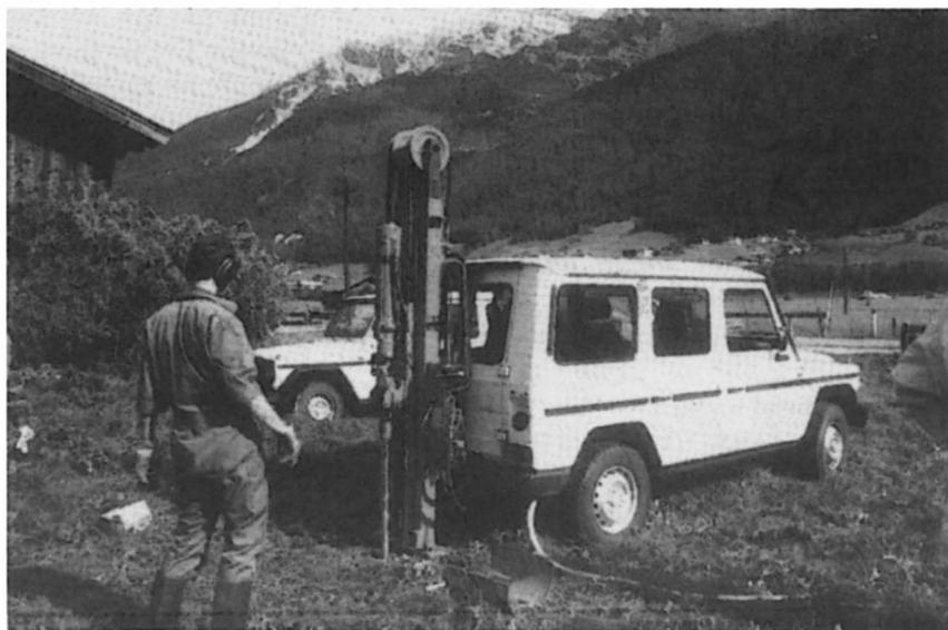
*Abb. 59: Kernbohrgerät und Kernbohrung bei Neustift/Stubai*
