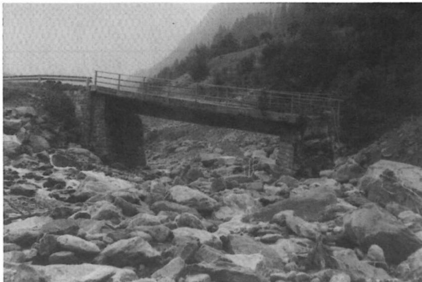
*Abb. 125: Bereich Falbeson: Brückentorso der alten Gletscherstraße nach Durchgang des Julihochwassers von 1987. Photo: Blättler 1987*
