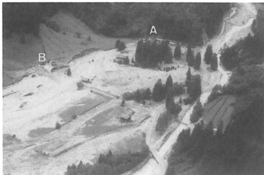
*Abb. 126: Falbesoner Aue nach den Hochwasserereignissen 1987. Die murartig abgehende Ruetz verkleuste die Brücke im Bereich "zwischen den Wänden", brach daraufhin nach rechts aus und überschotterte den gesamten Talboden. Die jahrhundertealte Falbesoner Alm (A) und die Doadler Alm (B) wurden dabei schwer in Mitleidenschaft gezogen. Photo: Wildbach- und Lawineniterbauung Innsbruck 1987*
