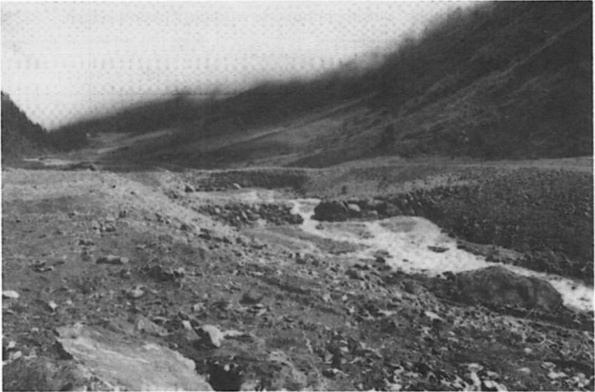
*Abb. 55: Au (etwa 15.000 m<sup>2</sup> dimensioniertes Geschiebeauffangbecken oberhalb der B'such Alm im Stubai Langental. Photo: Blättler 1987*
