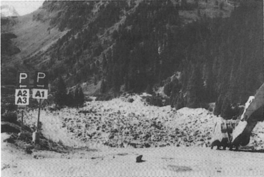
*Abb. 117: Mutterberg Alm: Der im natürlichen Retentions- und Hochflutbereich der Ruetz (eigentlich hier noch des Mutterberger Baches) angelegte Parkplatz wurde während des August-Hochwassers 1987 total zerstört. Photo: Blättler 1987*
