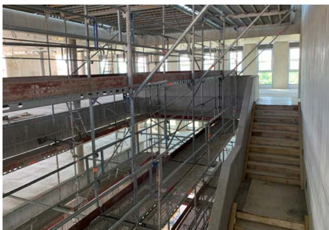
Das offene Atrium erschließt den künftigen Forschungsbau. (Bild: Staatliches Bauamt Würzburg)
