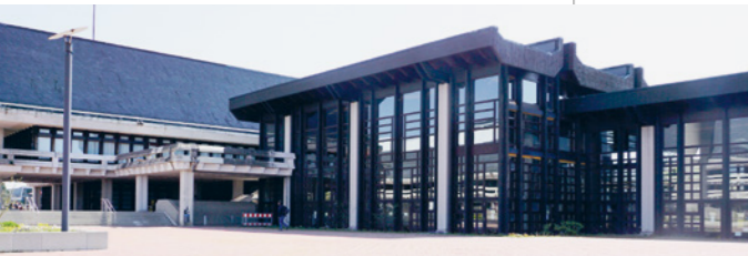
Die Sanierung der Hubland-Mensa inklusive Nebengebäude und Tiefgarage beginnt.
