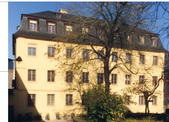
Im Müller-Thurgau-Haus in der Klinikstraße, das zu einem Universitäts- und Seminarzentrum umgebaut wurde, wird 2021 das Friedrich-Wilhelm-Joseph-Schelling-Forum der Bayerischen Akademie der Wissenschaften und der JMU eingerichtet.
