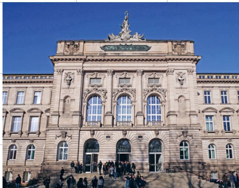
2014 beginnen die Baumaßnahmen zur Sanierung der Universität am Sanderring.
