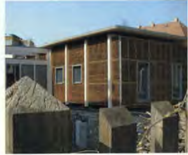
Der Neubau für die zentrale Zytostatika-Zubereitung wurde an die Apotheke des Uniklinikums angeschlossen. Foto: Emmerich
