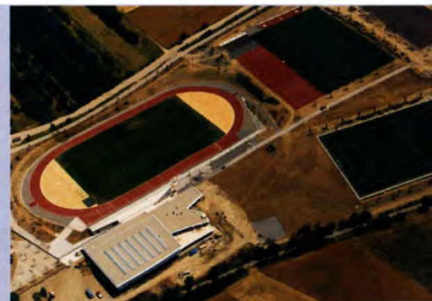
Weit vorangeschritten ist der Bau einer neuen Sportanlage im Zuge der Verlagerung des Universitätssports aus der Mergentheimer Straße zum Hubland (2003)
