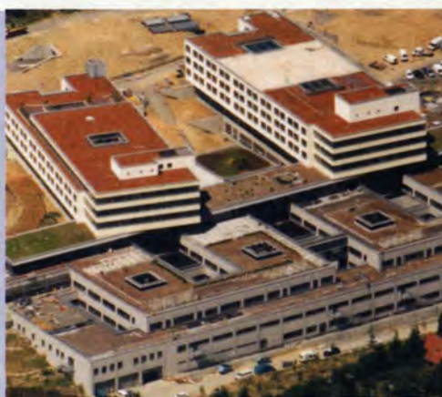
Baufortschritt an der neuen Chirurgie (2003)
