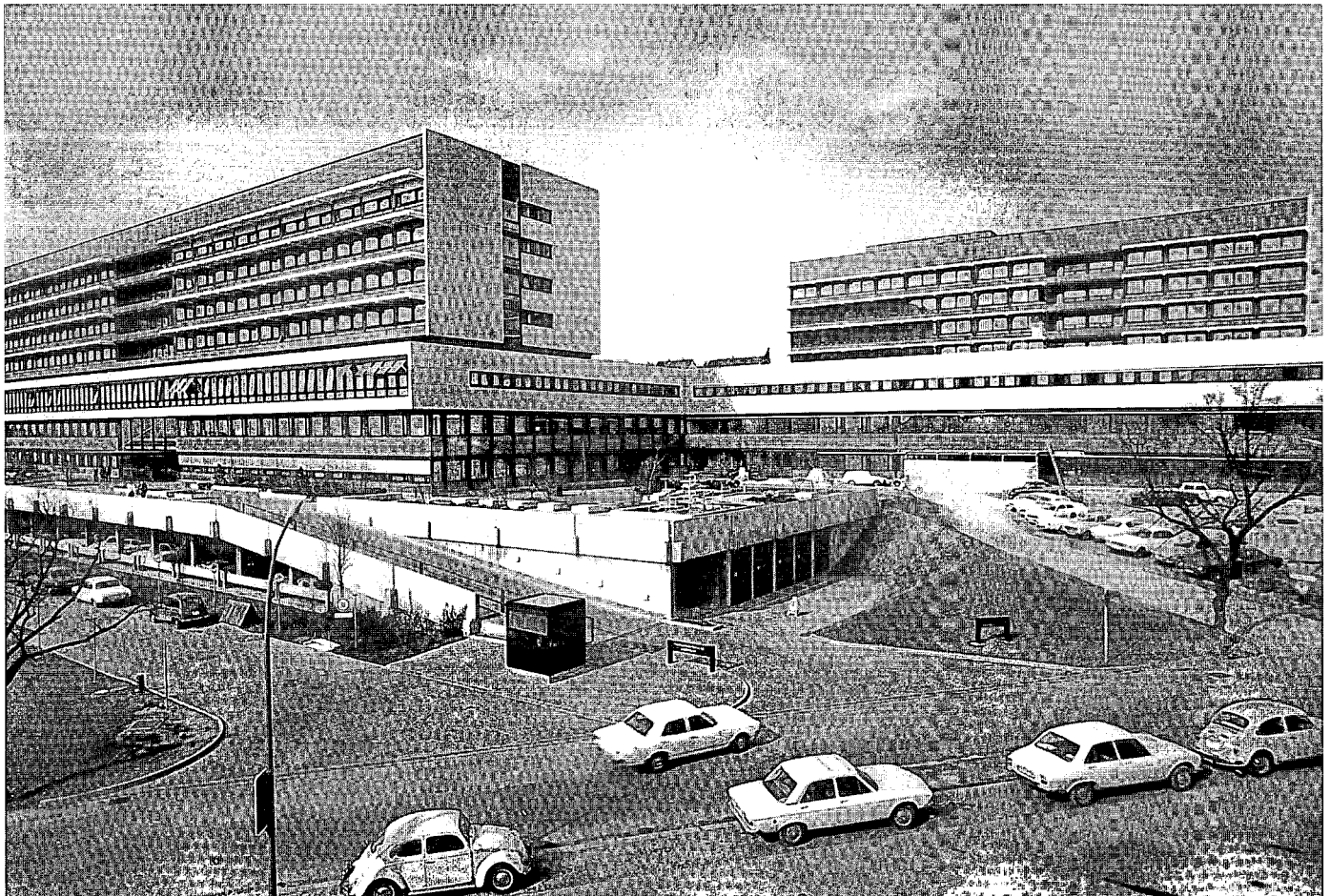
Kopfklinikum in der Josef-Schneider-Straße – inbetriebnahme vor 30 Jahren
