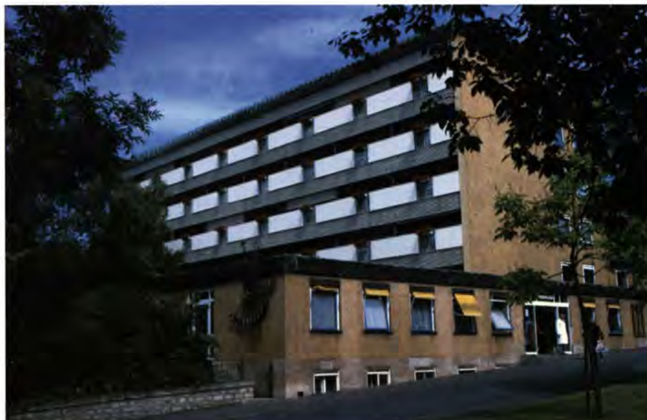
Abb. 6: Bau 34 von Südosten.
