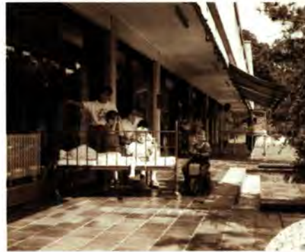
Abb. 7: Station Moro von Südosten.
