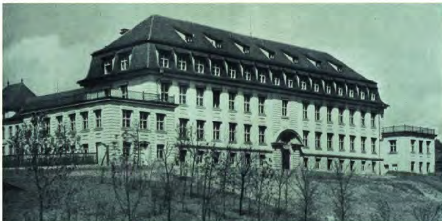
Abb. 4: Bau 18 von Südosten.
