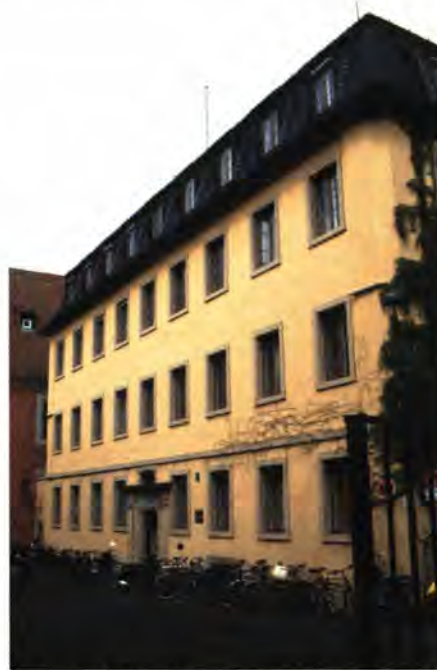
Abb. 1: Ehemalige Kinderklinik, Klinikstraße 3, von Südosten gesehen.
