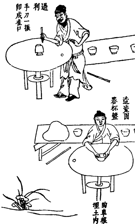
Schrittweise Darstellung der Produktion von Tonwaren im „Tiangong kaiwu“: Gezeigt ist das Formen (unten) und Polieren (oben) mit Hilfe einer Töpferscheibe.
