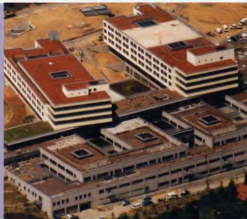
Baufortschritt an der neuen Chirurgie (2003)
